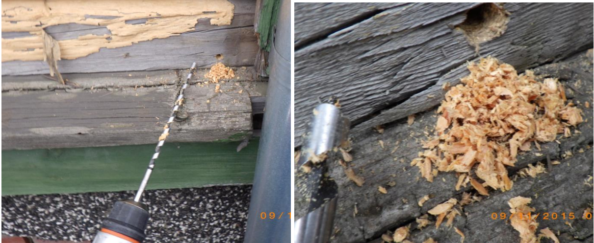
Kuva 5. Alimman seinähirren kuntoa tutkittiin poraamalla yhdeksästä kohdasta eri puolilta rakennusta. Hirsikehikossa ei havaittu merkittäviä lahovaurioita tai viitteitä hyönteisten aiheuttamasta tuhoutumisesta.
