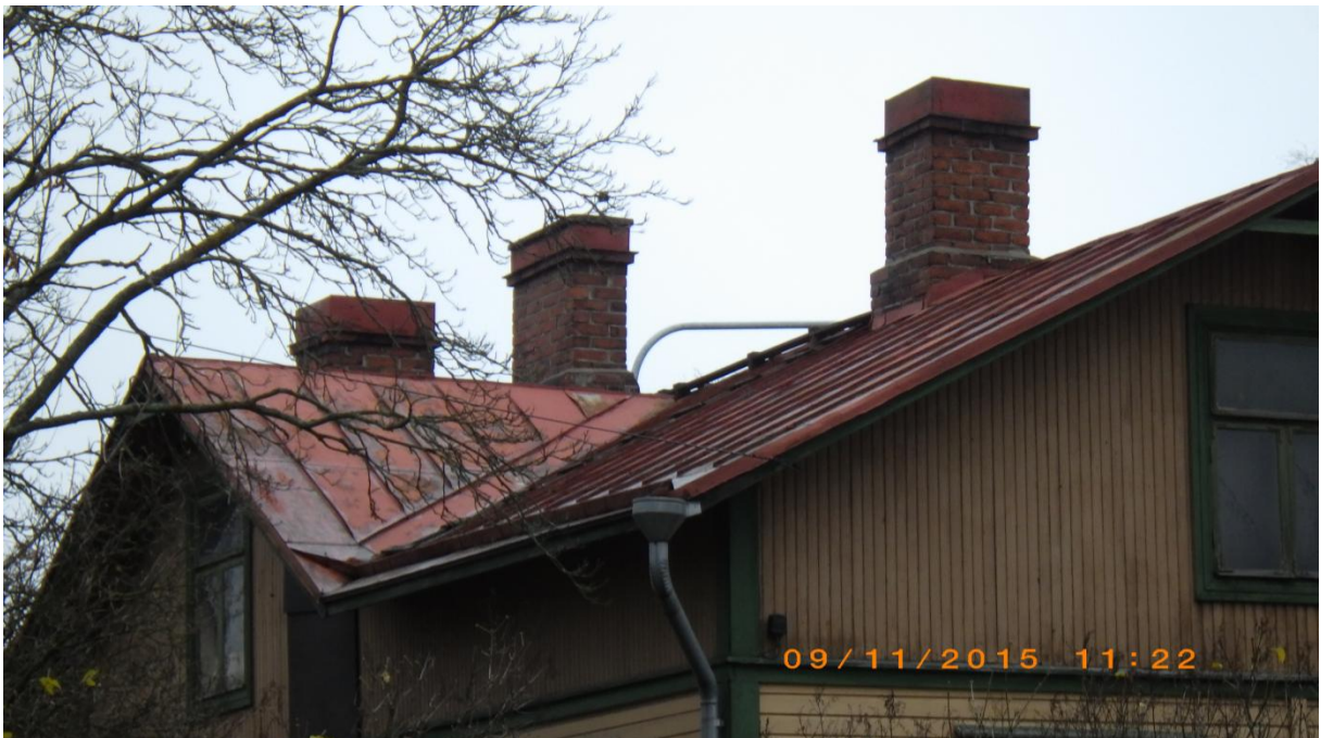
Kuva 9. Vesikatto pihalta kuvattuna.
